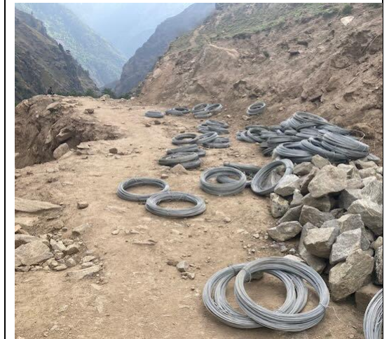
तस्वीर ३०: सडक सुधारका लागि ग्याबियन्स निर्माण गर्ने सामग्री
