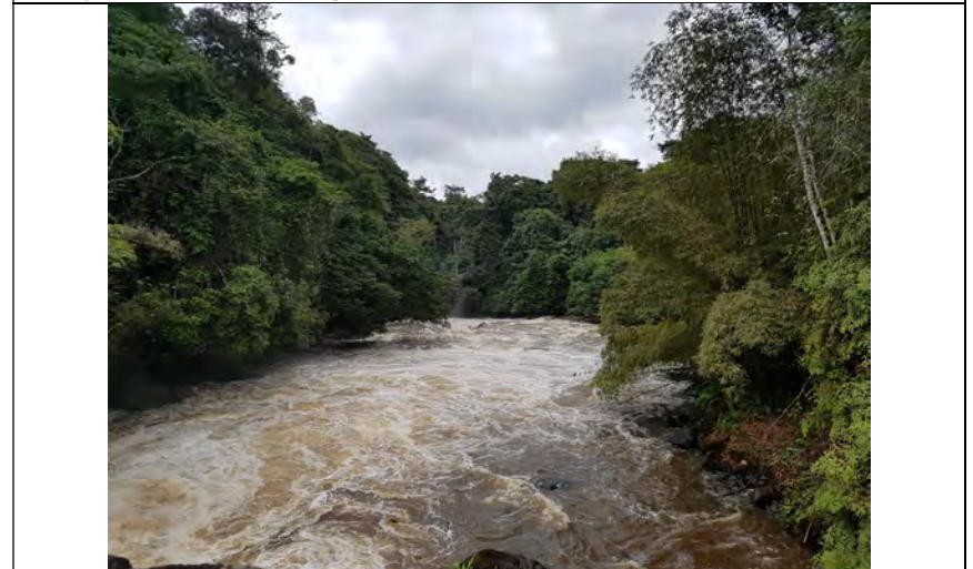
3.4 Vue du bras en rive droite de la Louétsi, en aval de l'ancienne microcentrale hydroélectrique à Mandji (en panne depuis 2000).
