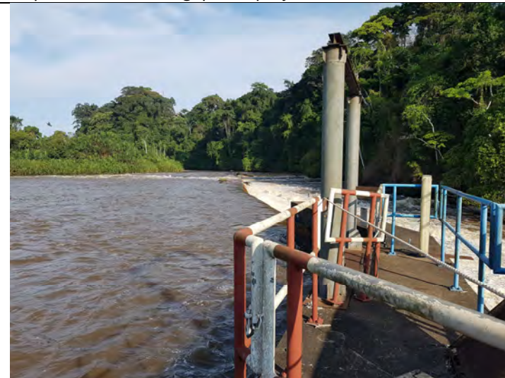
3.16 Vue en amont de la centrale hydroélectrique de Bongolo.
