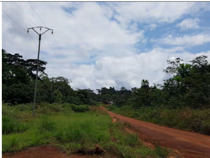
3.11 Ligne électrique reliant Mandji à Inounou qui ne distribue plus d'électricité depuis 2004.
