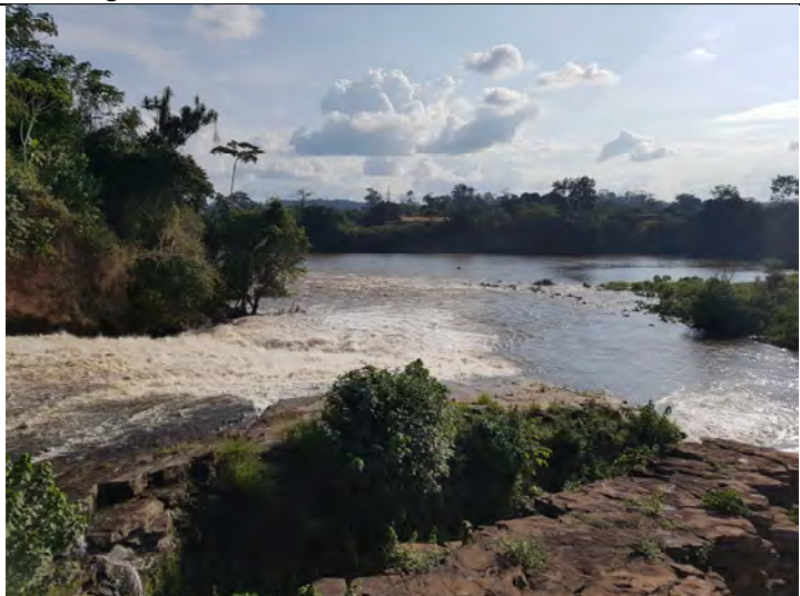
3.15 Vue des chutes en aval de la centrale hydroélectrique de Bongolo.
