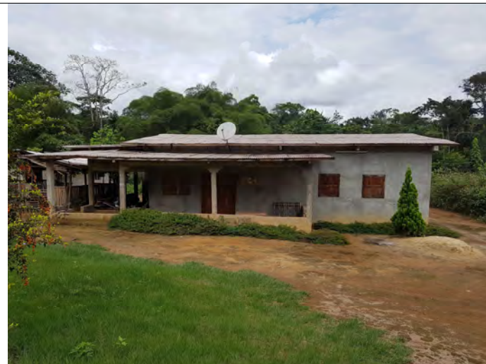
3.12 Maison entre Mandji et Dibwangui qui sera affectée par le projet et le seul ménage sujet à la relocalisation.
