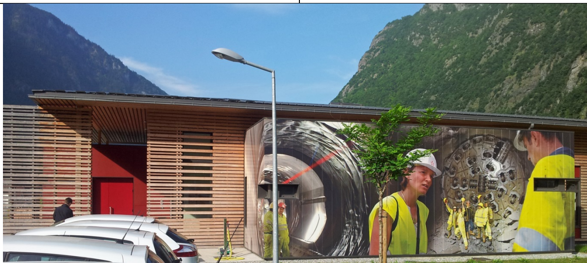
Photo 15: Maison Romanche Energie
