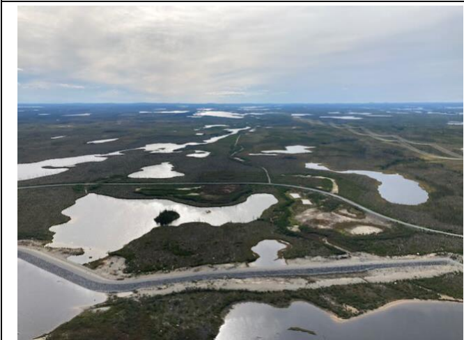
Photo 76 : Dignes en matériaux meubles sur le bief aval de la dérivation Rupert
