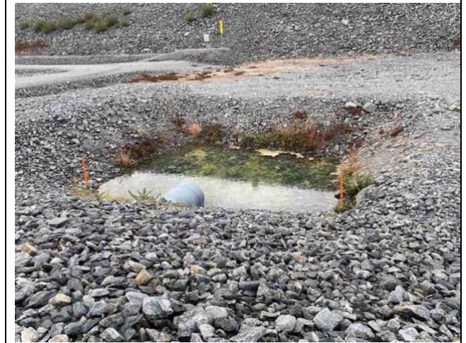
Photo 54 : Contrôle des infiltrations parasites sous le barrage Bernard-Landry
