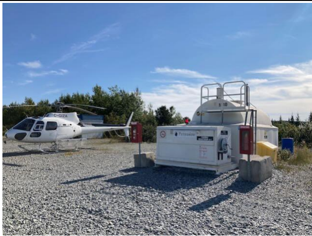
Photo 22 : Station de ravitaillement pour hélicoptères
