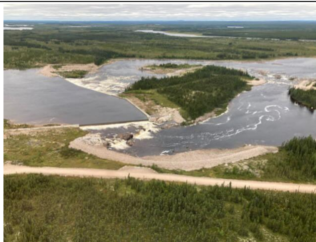
Photo 92 : Déversoir de la rivière Rupert
