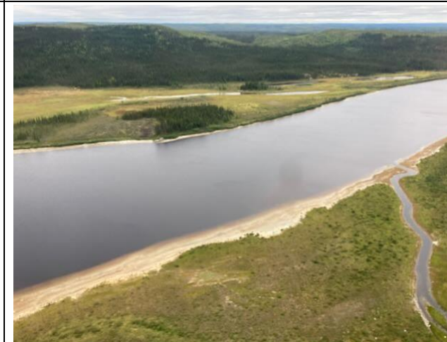
Photo 90 : Section à niveau d'eau réduit
