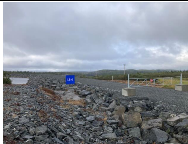
Photo 47 : Accès restreint au barrage en matériaux meubles
