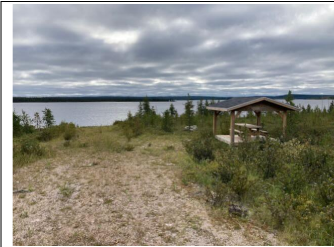
Photo 97 : Rampe de mise à l'eau avec abri au-dessus du déversoir
