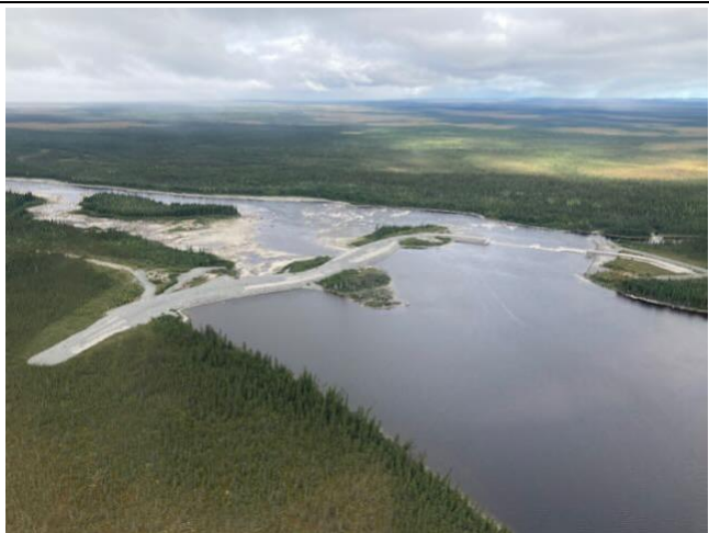
Photo 94 : Déversoir de la rivière Rupert
