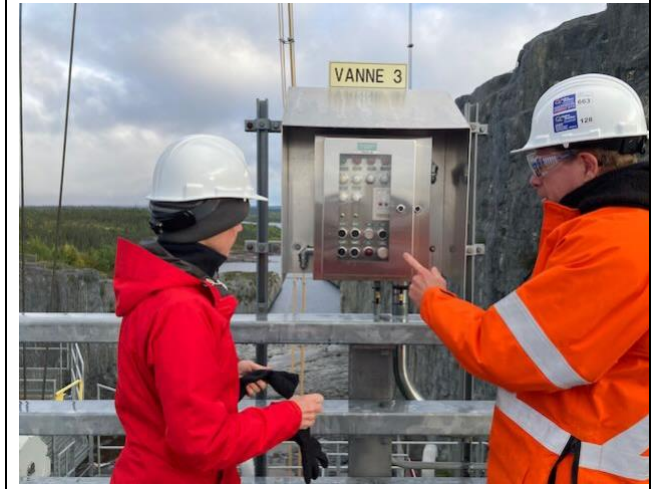
Photo 57 : Contrôle des vannes de l'évacuateur
