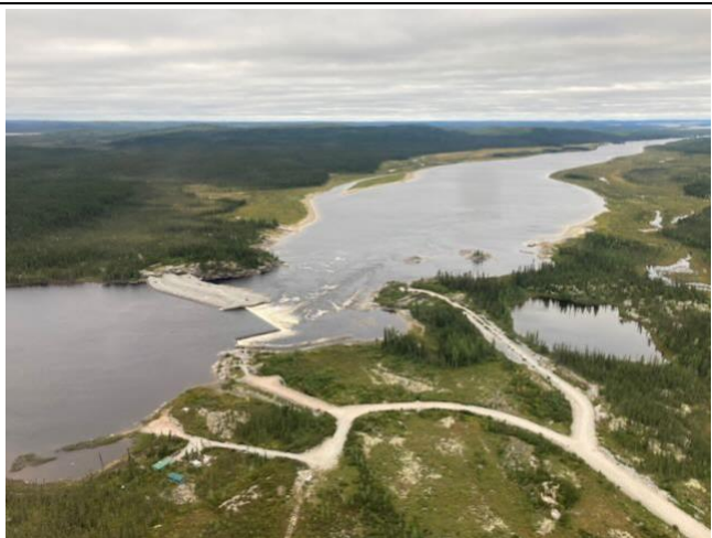
Photo 91 : Déversoir de la rivière Rupert
