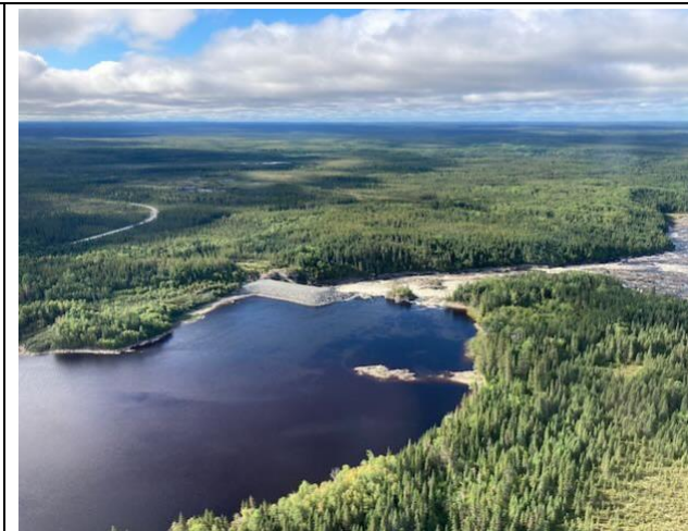
Photo 93 : Déversoir de la rivière Rupert
