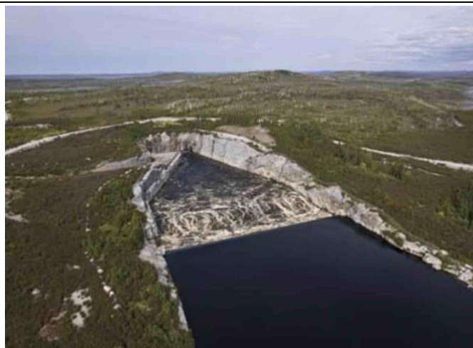
Photo 74 : Prise d'eau du tunnel de transfert Tommy-Neeposh
