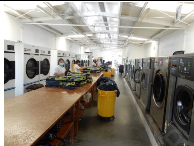
Foto 64: Lavandería campamento CCC
