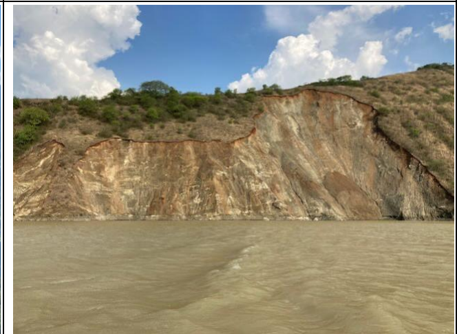
Foto 6: Talud inestable en el embalse 1
