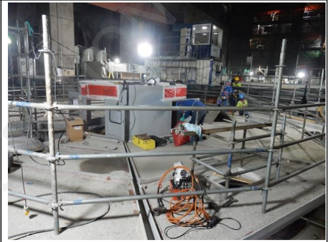
Foto 75: Condiciones de trabajo en la casa de máquinas
