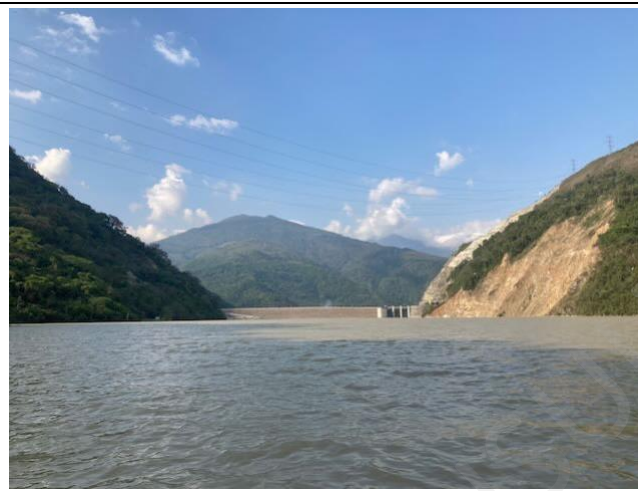
Foto 32: Vista de la presa desde el embalse
