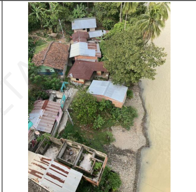
Foto 93: Viviendas en Puerto Valdivia afectadas por inundación durante contingencia
