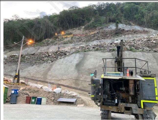
Foto 17: Estabilización de taludes a 0+900
