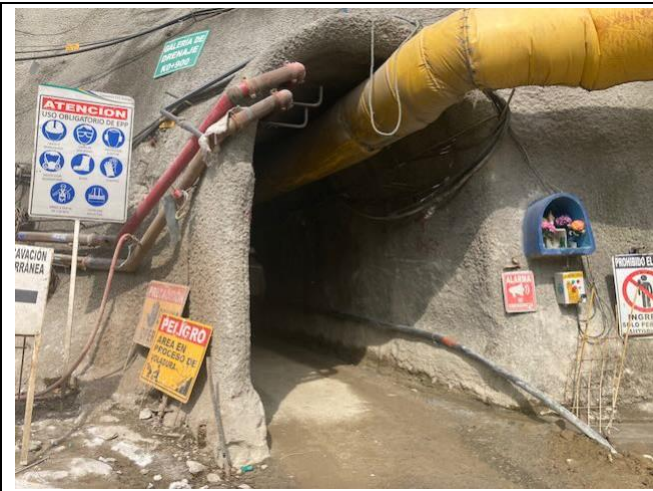
Foto 19: Señalización de seguridad y ventilación en túnel de drenaje para estabilización de taludes a 0+900
