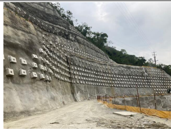
Foto 34: Estabilización de taludes sobre presa en margen derecha
