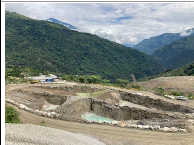
Foto 48: Disposición de residuos líquidos de trampas de sedimentos en Ticuita
