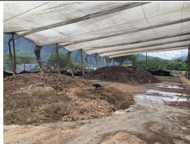
Foto 65: Instalación de compostaje en el campamento CCC
