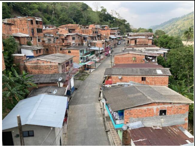
Foto 90: Puerto Valdivia en la margen izquierda del río Cauca
