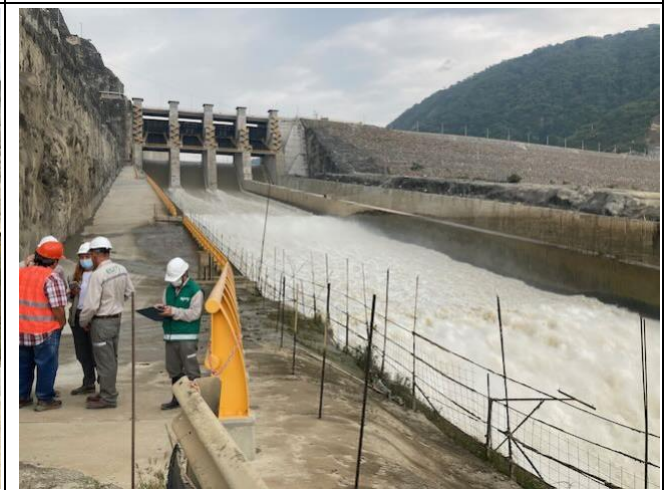
Foto 36: Aliviadero en funcionamiento
