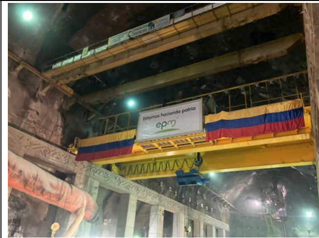
Foto 72: Techo de la caverna de la central eléctrica
