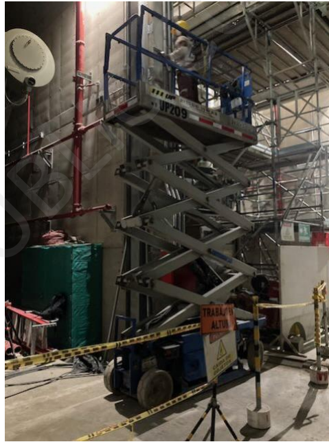
Foto 77: Trabajo en alturas
