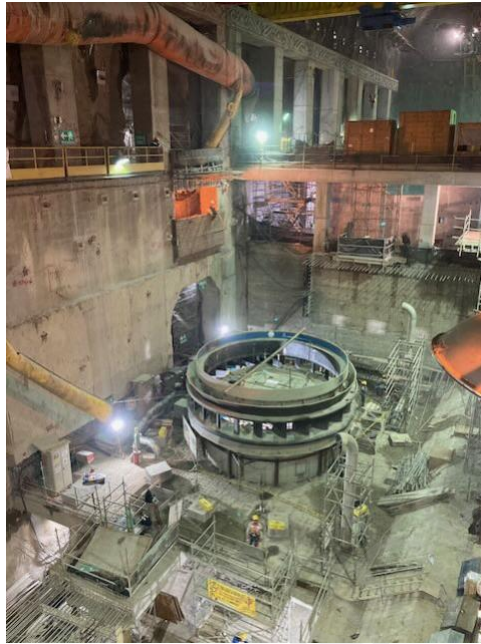
Foto 76: Montaje de unidades de generación
