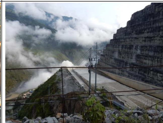
Foto 42: Vertedero desde la cresta de la presa
