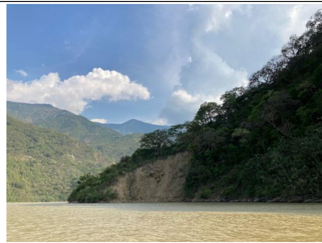
Foto 7: Talud inestable en el embalse 2
