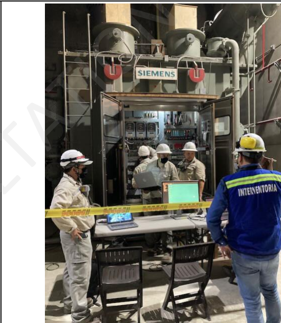
Foto 69: Trabajos de montaje en caverna de transformadores
