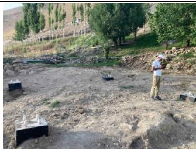
Фотография 74: Фундаменты опор ЛЭП в селе Верхний Чагев
