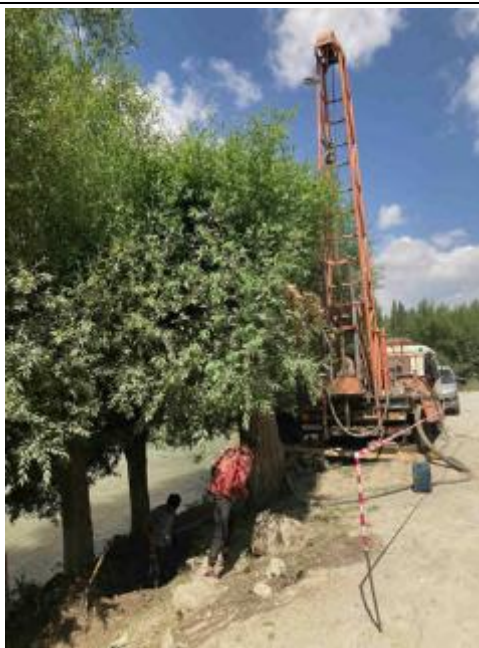
Фотография 32: Пробное бурение на мосту выше по течению от водозабора
