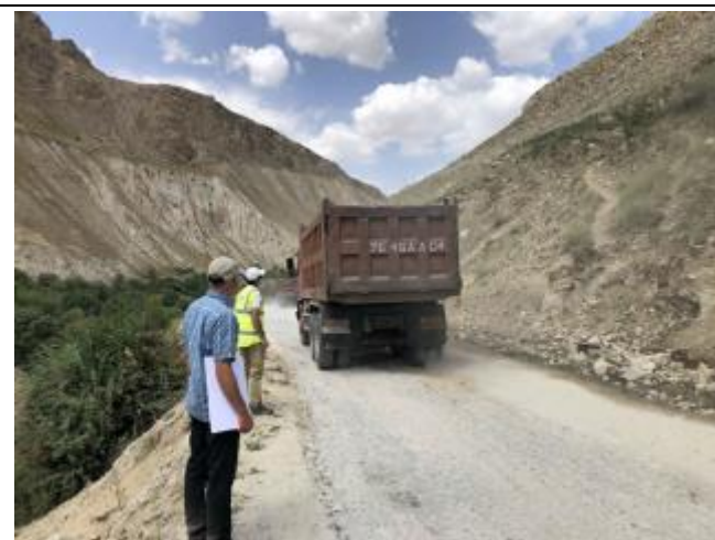
Фотография 43: Движение строительной техники
