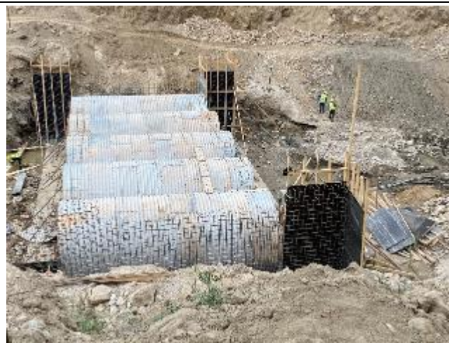
Фотография 86: Отводной канал реки со строящимся мостом
