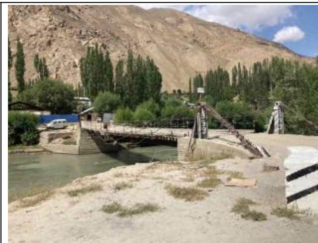
Фотография 27: Старый мост перед водозабором
