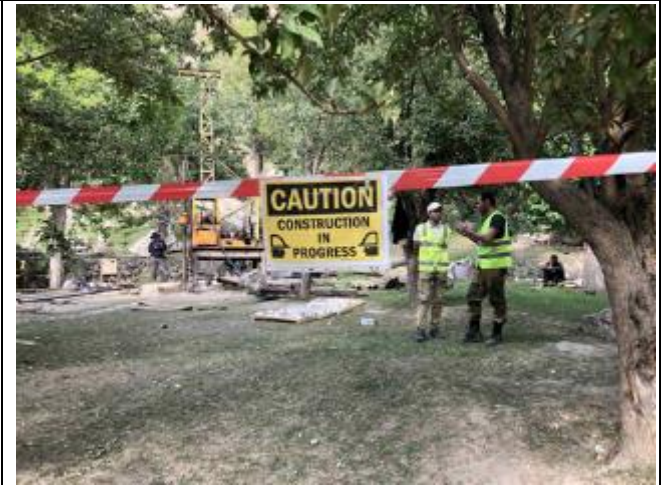
Фотография 66: Вывеска перед буровой установкой на участке электростанции
