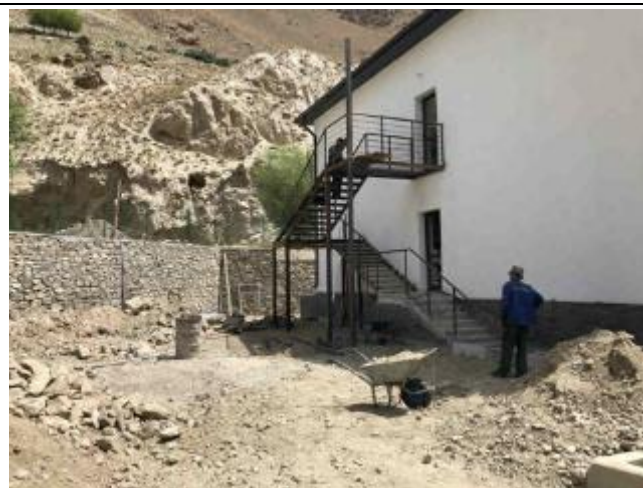
Фотография 47: Отделочные работы в здании Себзорской ГЭС в ПЭК
