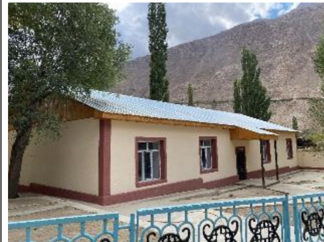
Фотография 114: Отремонтированный центр образования и культуры, который будет служить в качестве временной школы
