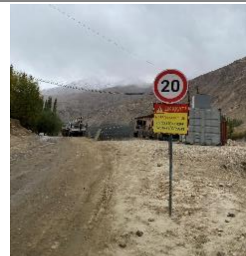
Фотография 90: Знак ограничения скорости на месте строительства водозабора
