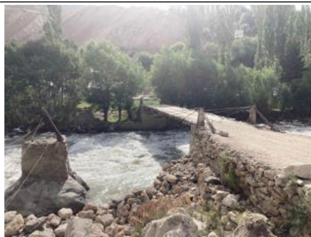
Фотография 53: Мост в село Себзор на левом берегу реки возле электростанции
